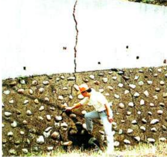
圖五：變形的擋土牆
