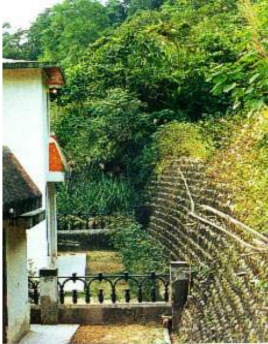
圖七：房子距離擋土牆腳或坡腳不可太近
