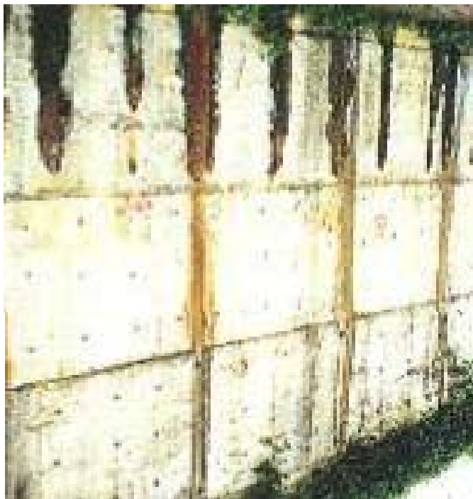
圖四：注意排水口的排水情形。
