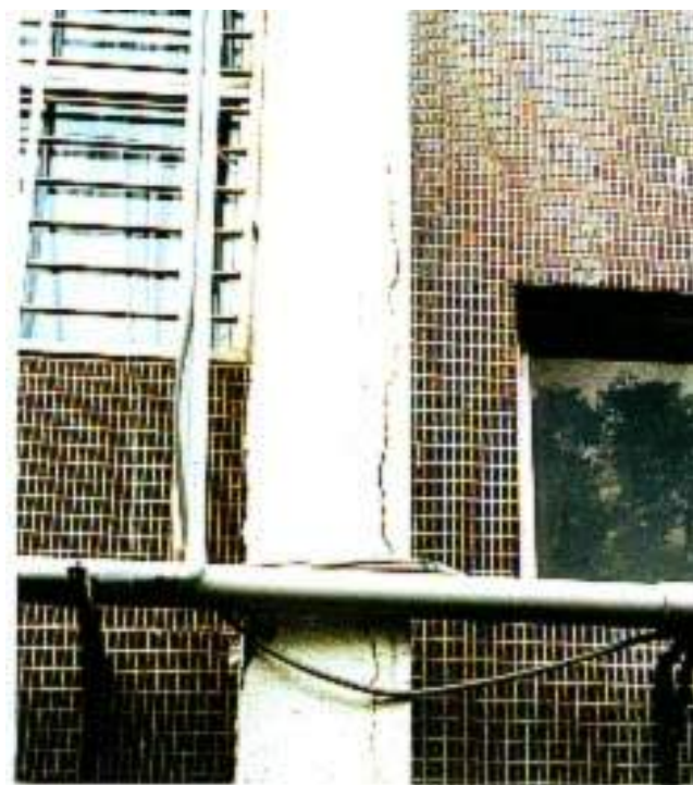
圖 3-5 房屋梁柱出現裂紋或歪斜現象
