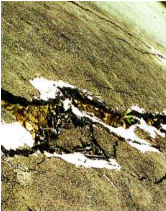
圖 3-2 邊溝和路面出現裂縫
