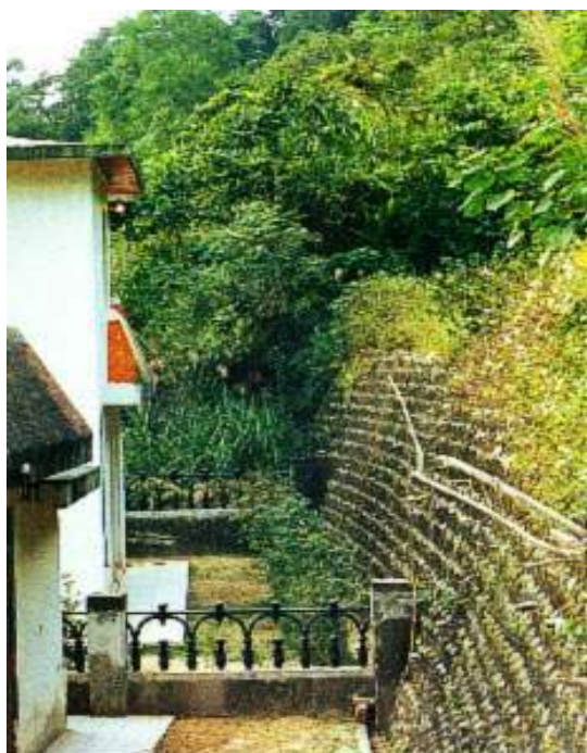
圖 3-7 房子距離擋土牆太近
