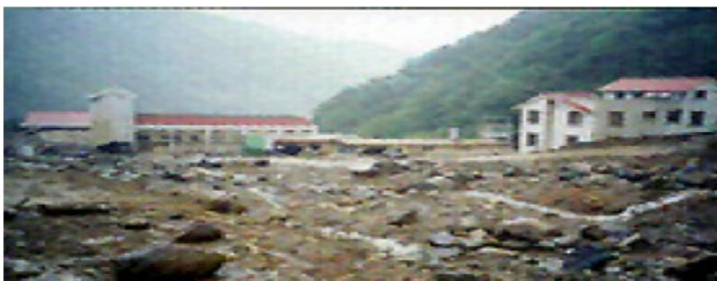
圖 2-2 土石流造成台北縣瑞芳鎮大粗坑的災情
