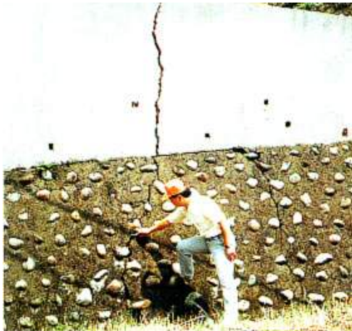
圖 3-6 擋土牆腳或坡腳龜裂或出現落石
