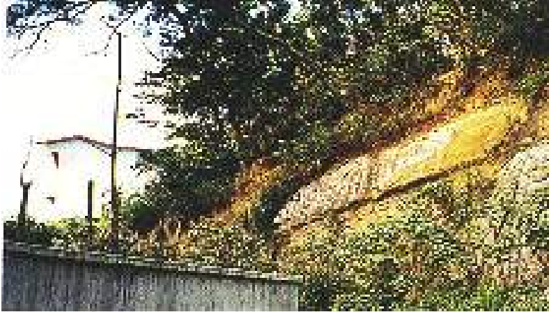
圖 3-1 坡地滑動所造成的樹木和電線桿傾斜
