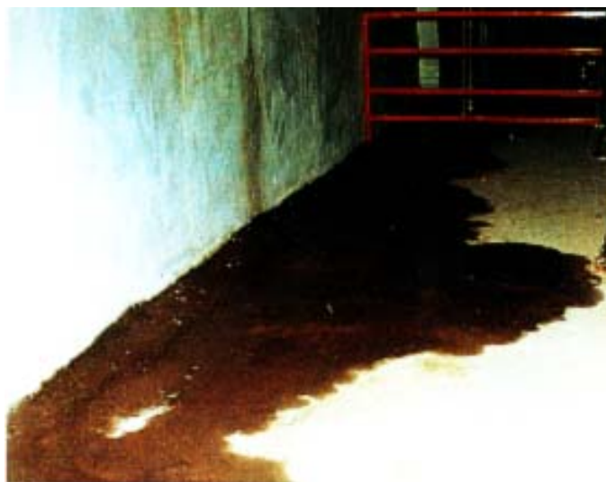
圖 3-3 地下室地板與牆壁出現滲水現象
