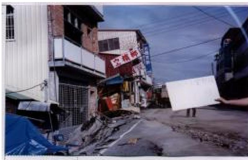
圖 12-1 石岡豐勢路斷層錯動，造成路面及鄰房的破壞 莊德興攝
