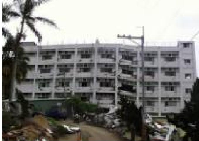
圖 12-3 斷層抬起結構物，造成結構物扭曲破壞
