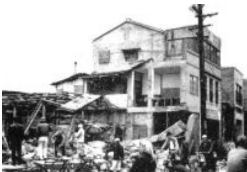
圖 13-9 新市市場，鋼筋混凝土柱木造房屋傾塌，水泥柱壓倒隔壁鋼筋混凝土柱，造成鄰屋之倒塌 徐明同、呂新民攝
