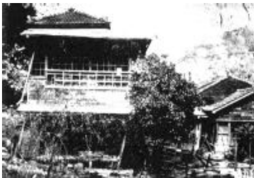
圖 13-7 關仔嶺木造二層建築物向北東東傾倒，向北北西攝 徐明同、呂新民攝
