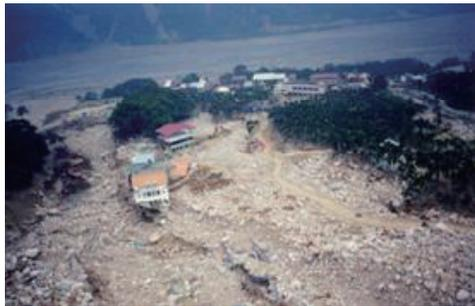
➤ 照片12-5 土石流堆積部常位於平緩的溪谷出口處
