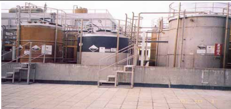
圖 6-6 對於異類物品（雙氧水與次氯酸鈉）接觸有引起危險之虞者，已採取防止接觸之設施（防液堤隔離）。
