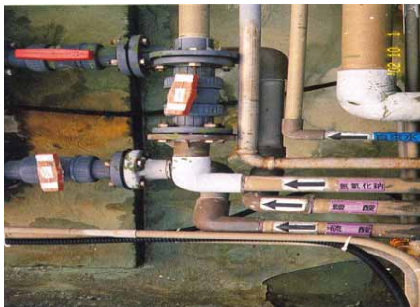
圖 6-8 對於化學設備或其配管，為防止危險物洩漏或操作錯誤而引起爆炸、火災之危險，操作化學設備或其配管之閥及控制開關，均保持良好性能，標示其開關方向。
