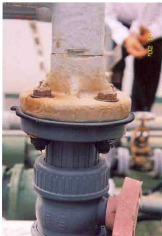
圖 6-7 對於化學設備或其配管，為防止危險物洩漏或操作錯誤而引起爆炸、火災之危險，化學設備或其配管之接合部分，已使用墊圈使接合部密接。
