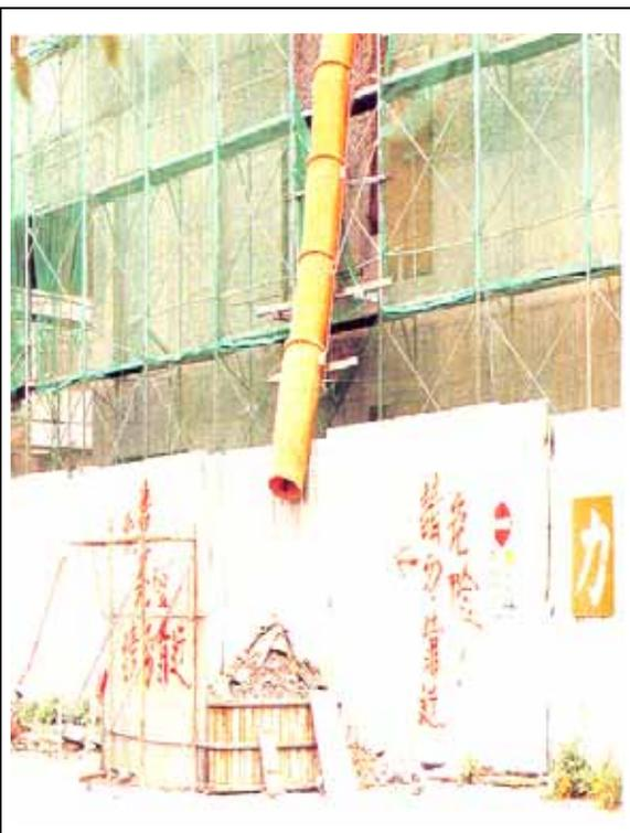
圖 7-7 設置滑槽及承受設備。
