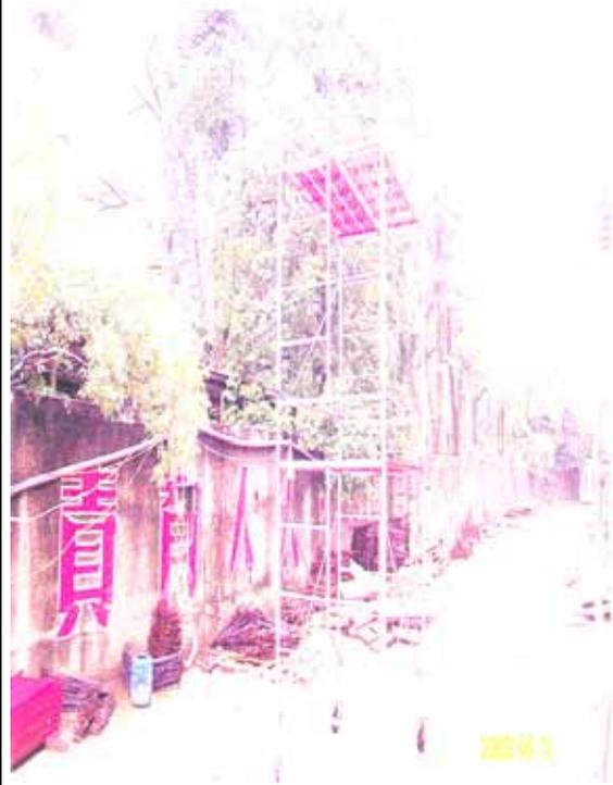
圖 7-3 於高度二公尺以上之處所進行作業之施工架
