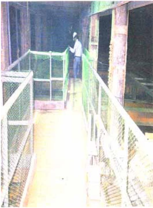
圖 7-2 高度在二公尺以上之工作場所邊緣及開口部份，已設置適當強度之圍欄
